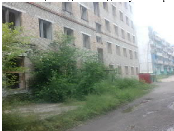
Контейнерная площадка для жилых домов, ул. Набережная, 7, 9, 10, 12, 17.07.2021, 12:00
