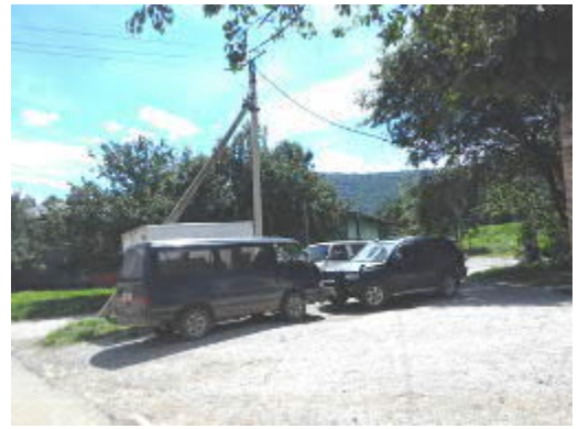
Опора ЛЭП жилого дома ул. Набережная, д. 12, 17.07.2021, 13:25
