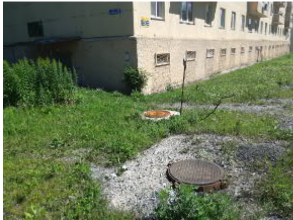
Люки подземных коммуникаций ул. Набережная, д.5, 17.07.2021, 10:20
