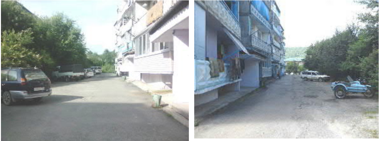
Общий вид жилого дома ул. Metallургов, д. 6, 18.07.2021, 10:20
