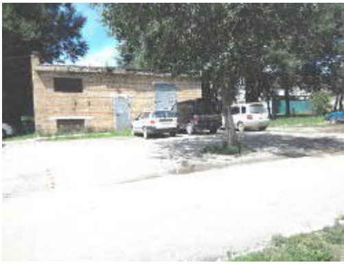
Трансформаторная подстанция жилого дома ул. Набережная, д. 12, 17.07.2021, 13:20
