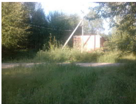
Трансформаторная подстанция жилых домов ул. Дымова 1, 2, 19.07.2021, 13:45
