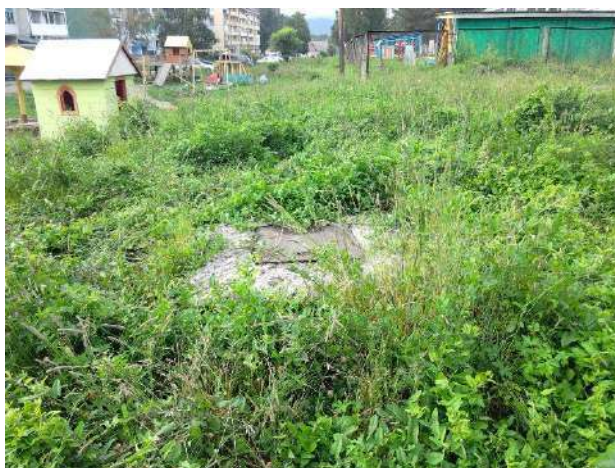
Люк подземных коммуникаций жилого дома ул. Молодежная, д.5, 13.07.2023, 09:44
