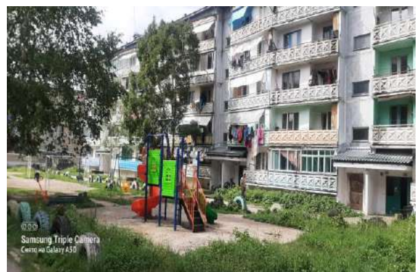
Общий вид жилого дома ул. Набережная, д. 20, 12.07.2023, 13:00
